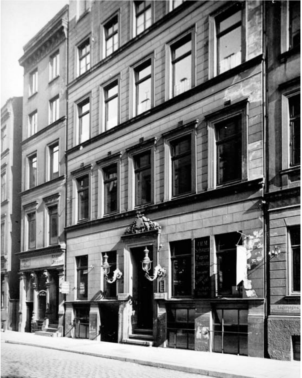
Das erste eigene Haus der Hapag an der Deichstraße 7 wurde 1870 bezogen
