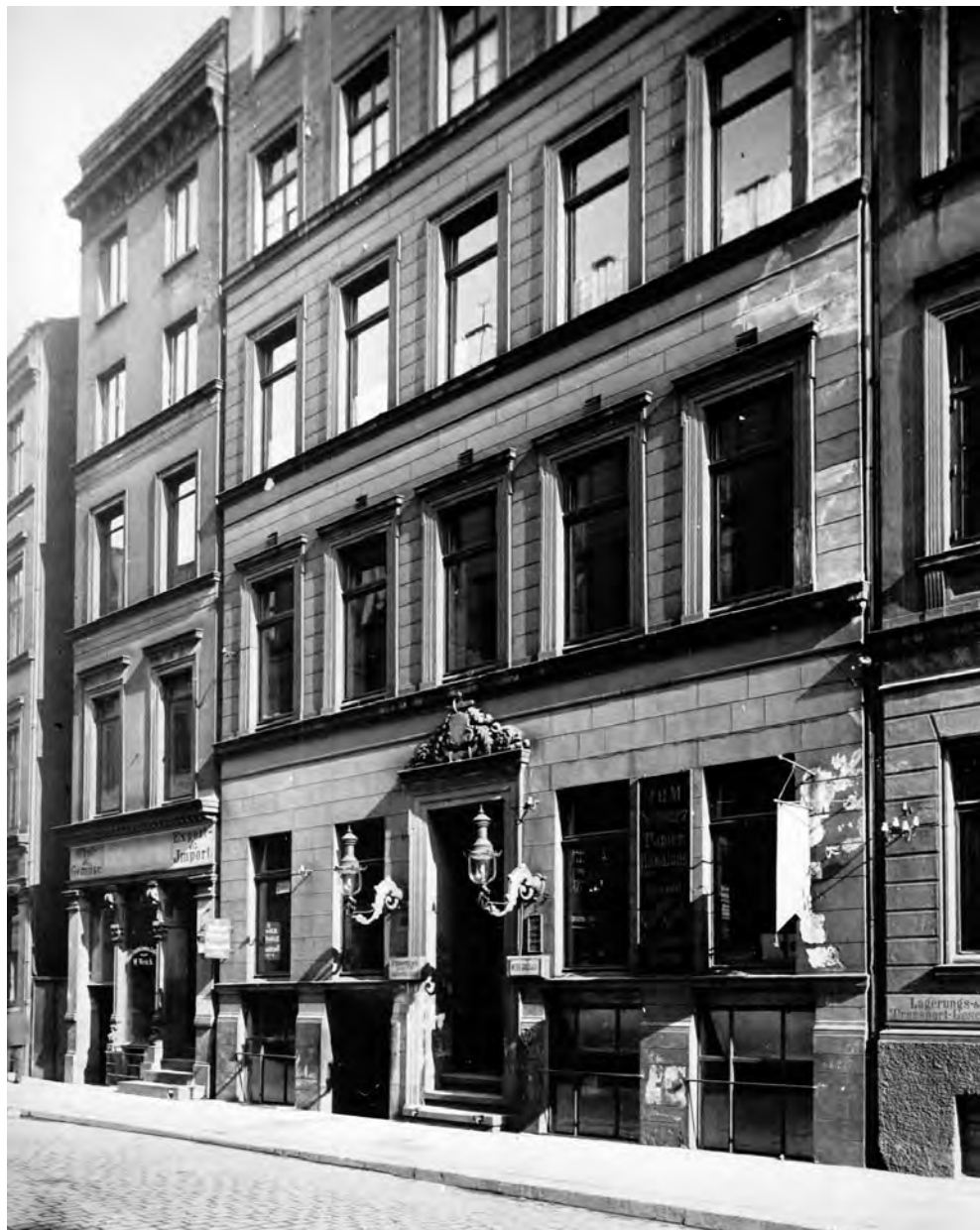
Das erste eigene Haus der Hapag an der Deichstraße 7 wurde 1870 bezogen
