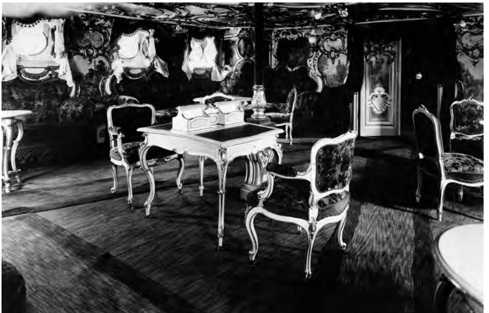
Damenzimmer und Lichtschacht der „Augusta Victoria“
