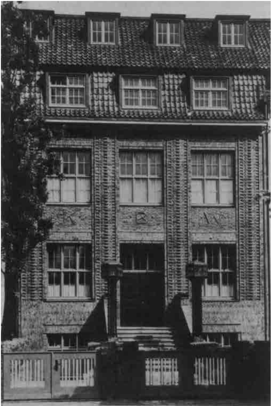
Das Gebäude der Kulturwissenschaftlichen Bibliothek – Fassade
