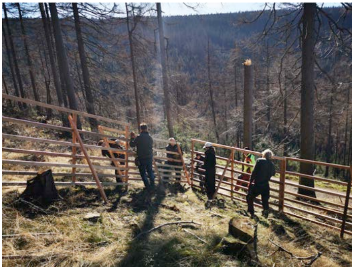
Abb. 40: Freiwillige beim Bau eines Hordengatters (eigene Aufnahme).
