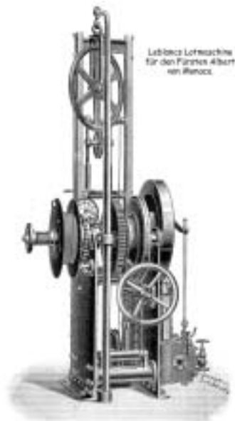
Abb. 8: Lotmaschine nach Leblanc, um 1905. Aus: Krümmel (1907), S. 77, Fig. 12.
