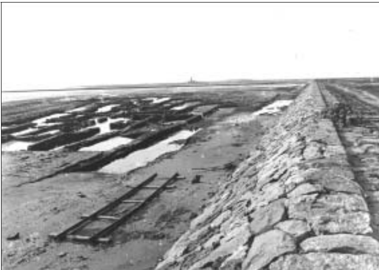
Abb. 24: Uferbefestigung auf Hallig Langeness, ca. 1925. Aufnahme: Theodor Möller, Archiv des Landeskonservators, Landesamt für Denkmalpflege Schleswig-Holstein.
