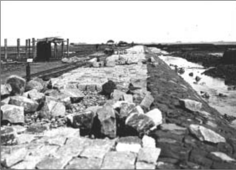
Abb. 23: Uferbefestigung mit Steinquadern auf Hallig Langeness, ca. 1925. Aufnahme: Theodor Möller, Archiv des Landeskonservators, Landesamt für Denkmalpflege Schleswig-Holstein.
