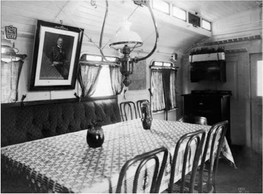
Aufenthaltsraum im Lazarettzug C1
