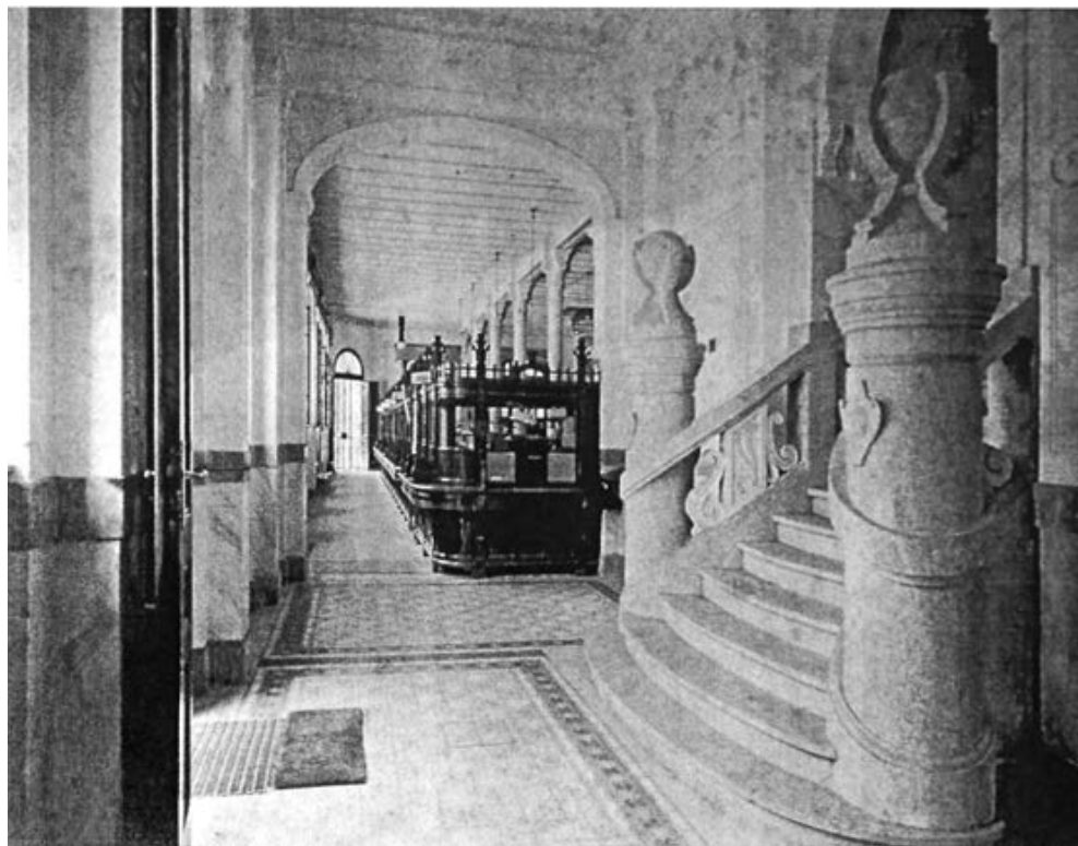
Eingangsbereich des Neubaus Herm. Stoltz & Cie., Rio de Janeiro (1906)
