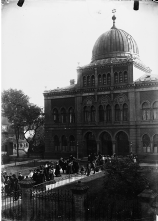
Die Lübecker Synagoge in der St.-Annen-Straße, 1904.
