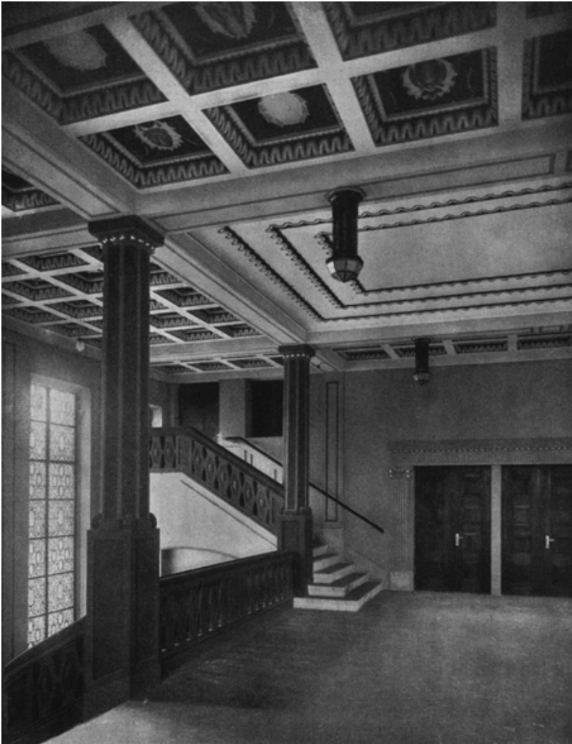
Abb. 4: Erahnte Farbigkeit – Haupttreppenhalle 1911
