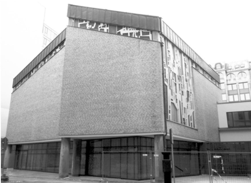
Abb. 6 a: Ev.-ref. Kirche in Hamburg, Ferdinandstraße 21, nach noch nicht ganz abgeschlossenem Umbau, hier Straßenseite
